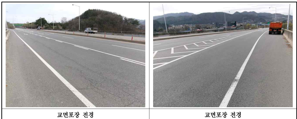
【사진 4.3.17】 교면포장 전경
