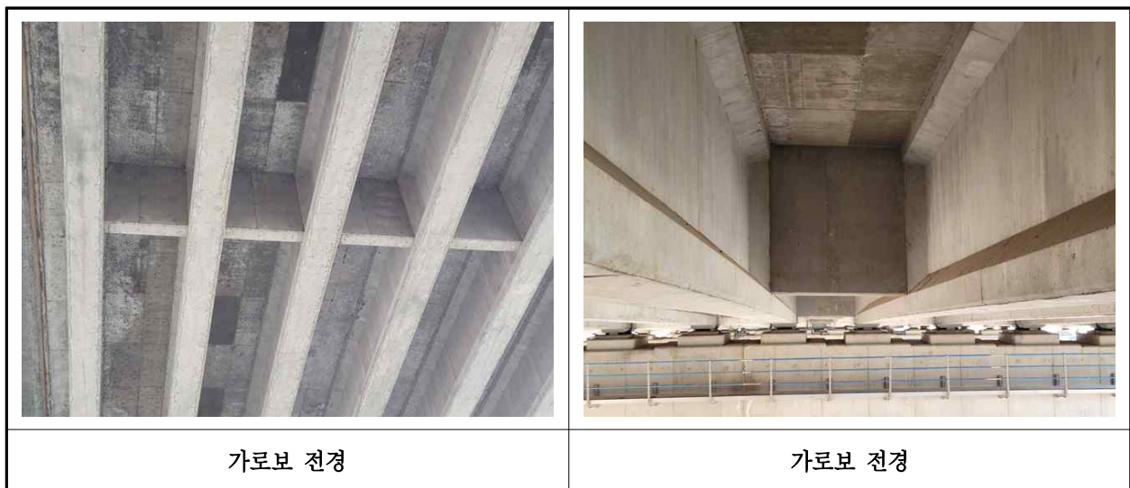
【사진 4.3.6】 가로보 전경
