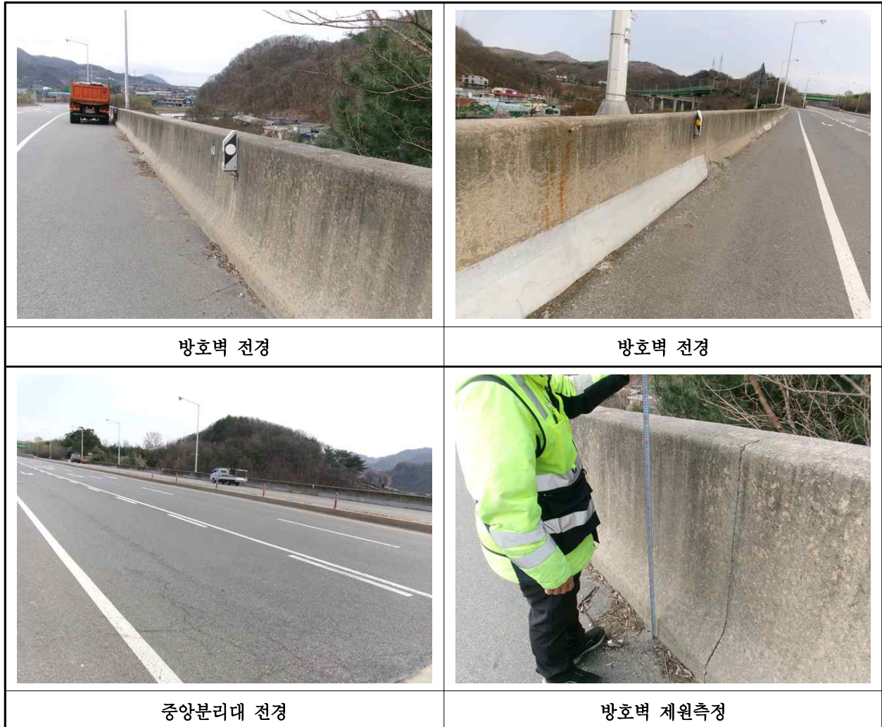
【사진 4.3.21】 난간 및 연석 전경
