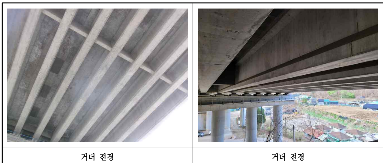
【사진 4.3.4】 거더 전경
