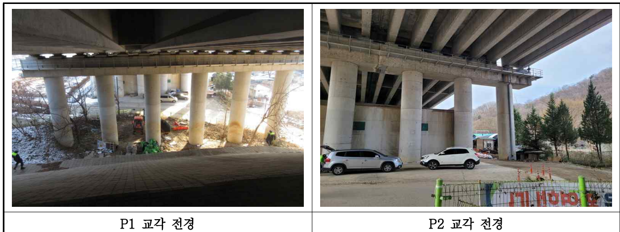
【사진 4.3.10】 교각 전경
