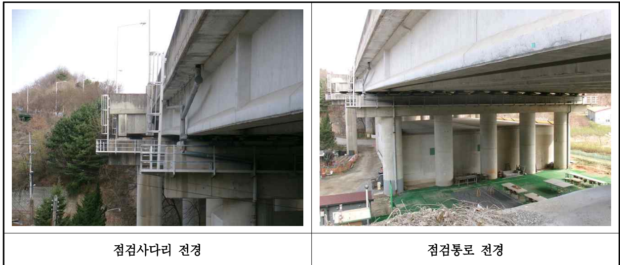
【사진 4.3.23】 교량 점검시설 전경
