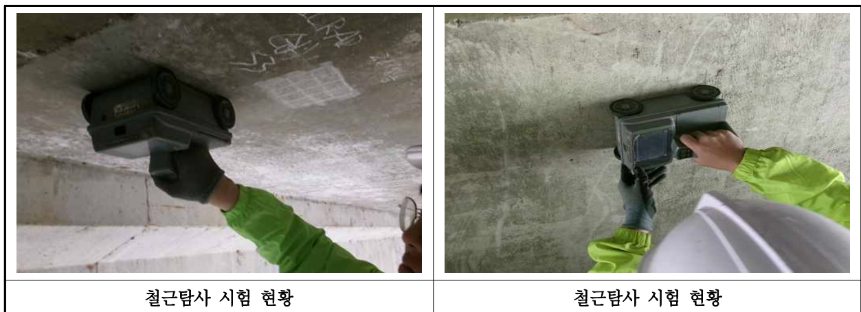
【사진 4.4.2】 철근탐사 시험
